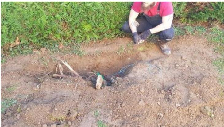
Après nombres coup de pioche et de pelle, nous retrouvons la gaine, décidons de l'ouvrir afin de tenter un aiguillage au plus proche du bouchon. Nous avons essayé différentes méthodes et types d'aiguilles et nous y sommes arrivés ! Une fois l'aiguille passée, HOP ! Un bout de ficelle et on retire en arrière ! Plus qu'à raccrocher la fibre au bout le jour j, et tout se passera bien. Et effectivement, tout s'est bien passé pour le déploiement final. Et c'est sur le visage d'un
